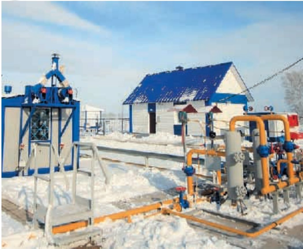
ГРС «Смоленская». Строительство пяти станций в селах Алтайское, Советское, Смоленское, Березовка и Усть-Иша – это финальная часть реализации масштабного проекта по газификации Алтайского края
